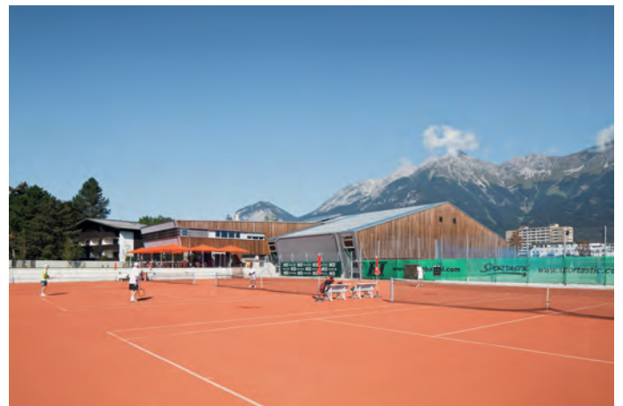
Unsere 2018 neu erbaute Tennisanlage in der Wiesengasse
